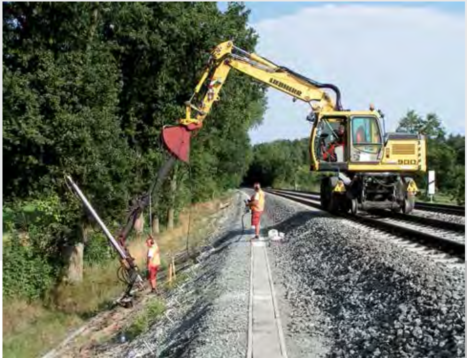
Böschungsvernagelung Ausbaustrecke JadeWeserPort Wilhelmshaven
