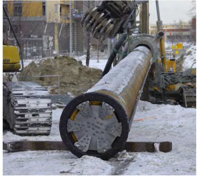
Figur 2: Rørsputt med pilotkrone, ringborkrone og spuntlås.
