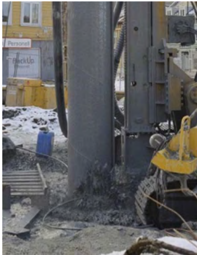
Figur 5: Luft kommer opp langs utsiden av røret.
