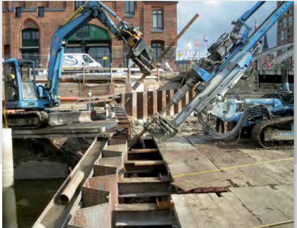
Rückverankerung der Pieranlage Elbtor Magdeburger Hafen, Hamburg
