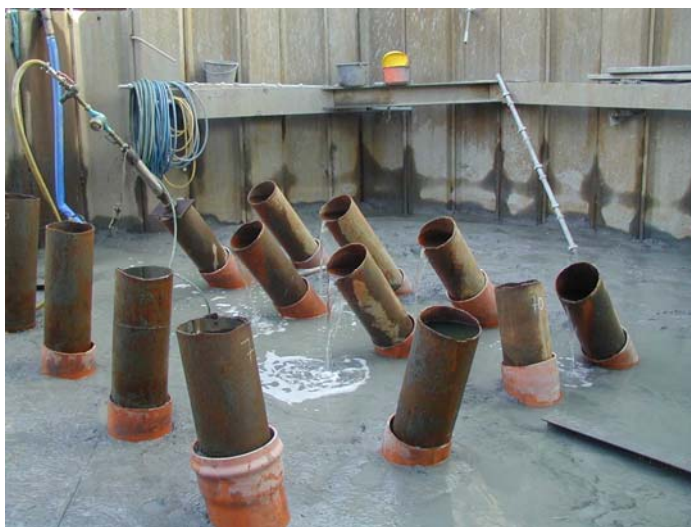
Figur 2-21. Vanntapsmåling i foringsrør for borede peler.
